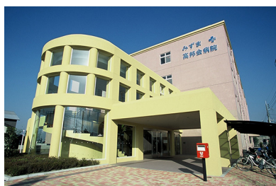
みずま高邦会病院（福岡県三潴郡大木町）
